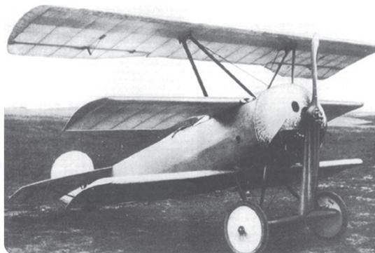
**Figura 12.38.** Avião de combate Fokker Dr. I, utilizado durante a Primeira Guerra Mundial construído com uma estrutura colada com adesivos à base de caseína.
