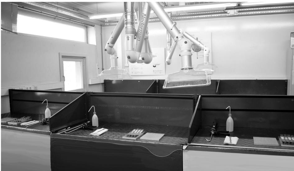
**Figura 7.4.** Laboratório com sistema de extração adequado para processos de colagem.
