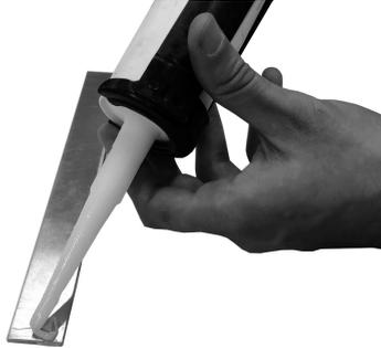
**Figura 5.5.** Processo de aplicação de um adesivo em pasta.
