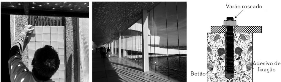
**Figura 1.10.** Aplicação de ligações adesivas na construção civil. Colagem de revestimentos cerâmicos (esquerda). Montagem e vedação de painéis de vidro (centro). Ancoragem de elementos roscados em betão (direita).
